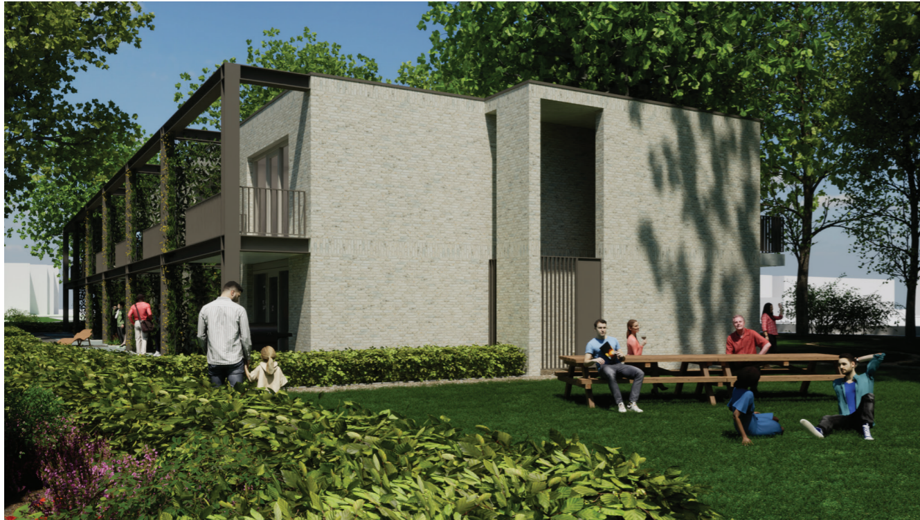
Zicht op entree startersappartementen en collectieve ontmoetingsruimte
