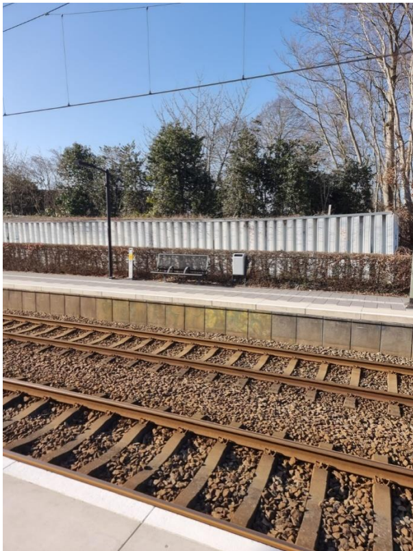
Figuur 5 Uitzicht vanaf het perron richting noordzijde spoorlijn (woningen Edward Poppelaan)
