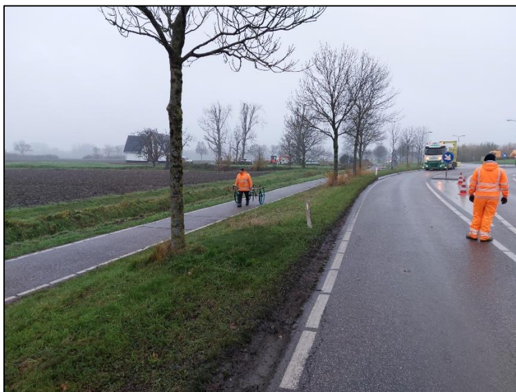
Afb.3 – Verkeersregelaar en botsabsorber tijdens detectiewerkzaamheden.
