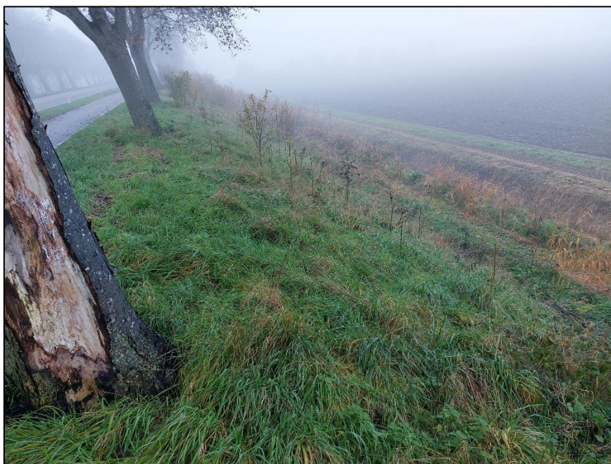
Afb.7 – Talud en bomen in het opsporingsgebied.
