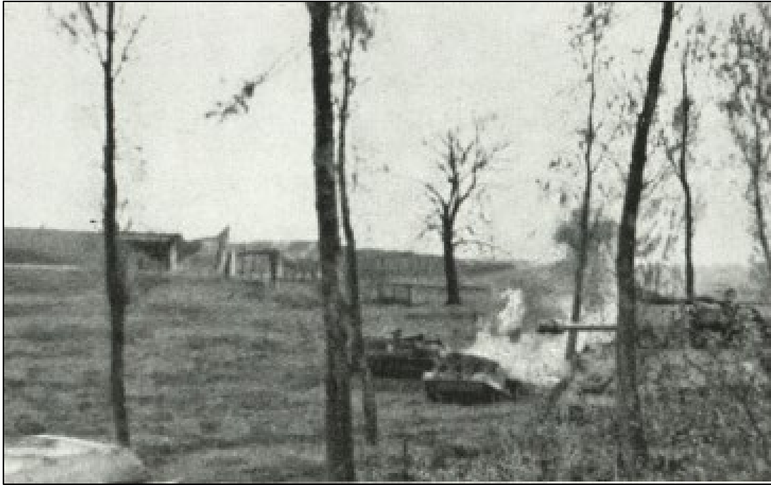
Afbeelding 28: Een brandende M10 en de vernielde brug bij de Nieuwe Veer. Bron: Didden Chill, 467.
