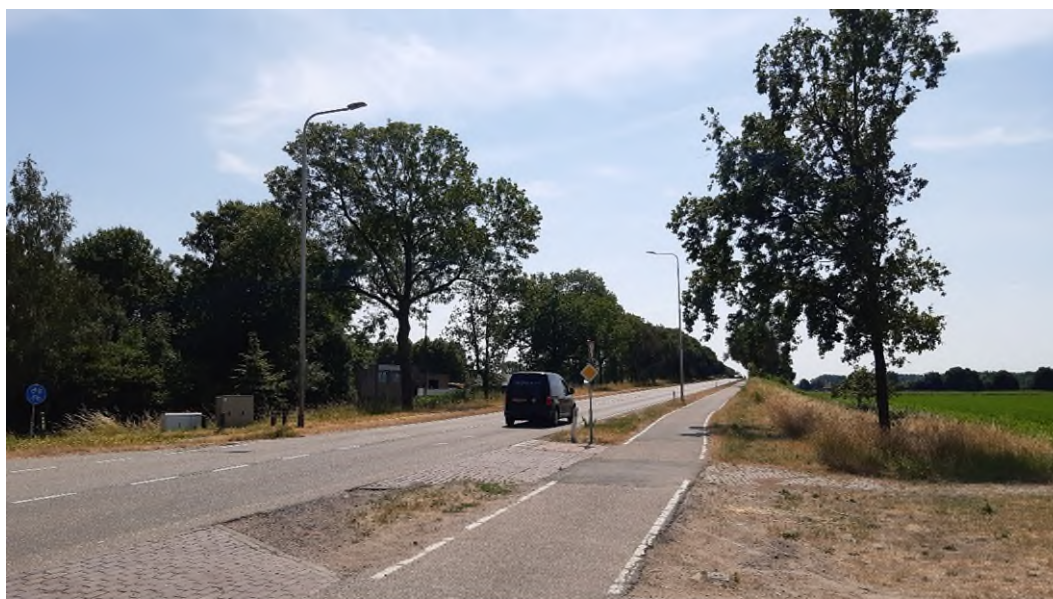
Afbeelding 11. Foto van de omgeving van de zone 2, gezien vanaf boring 12 in zuidoostelijke richting. Het talud van de weg is hier duidelijk te zien.
