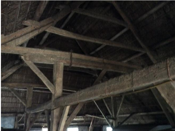
Figuur 4 | hoofddraagconstructie
