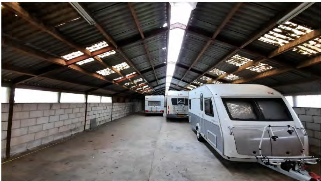
Binnenzijde voormalige kippenschuur. B. Verhoeven | Ecoresult B.V.
