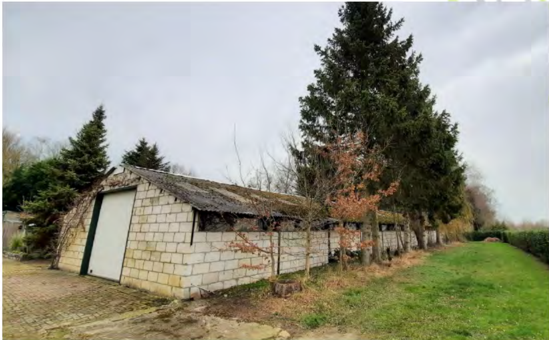
Voormalige kippenschuur, nu in gebruik als caravanstalling. B. Verhoeven | Ecoresult B.V.
