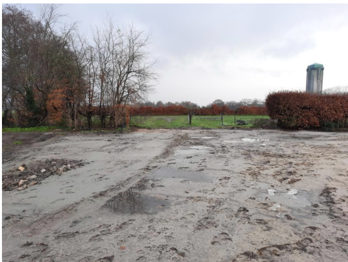
Foto 1: na sloop gebouw en verhardingen
