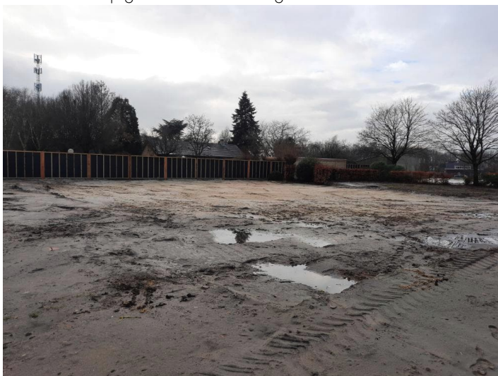
Foto 2: na sloop gebouw en verhardingen
