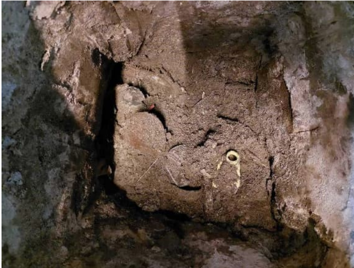
Foto: Gat ter plaatse van de werkplaats (deellocatie D06)
