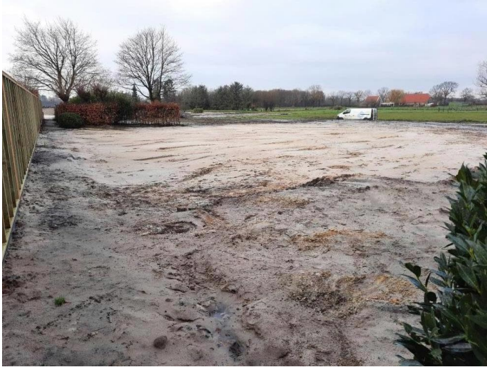
Foto 4: na sloop gebouw en verhardingen
