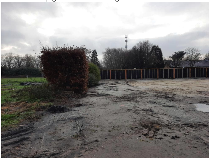
Foto 3: na sloop gebouw en verhardingen
